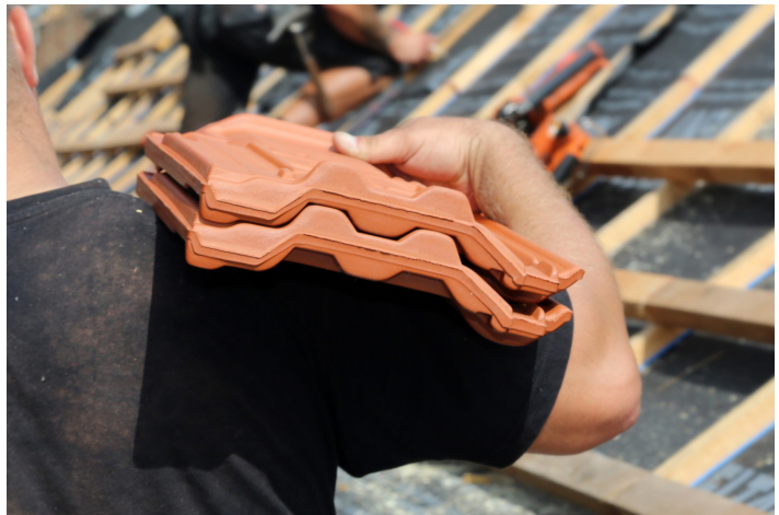
Dachdecker - Ein Job unter freiem Himmel.
