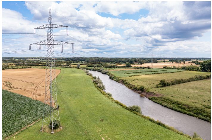
Mast 112 der 220-kV-Bestandsleitung Landesbergen - Lehrte (links am Mast das 110-kV-System der Avacon und rechts das 220-kV System von TenneT)
